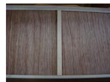
★ 底板裏- 補強板入り
